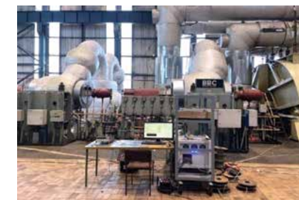
Испитивање турбине ТЕ Никола Тесла Б2
