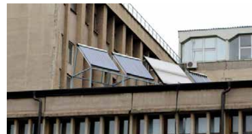
Соларни термички колектори на крову Машинског факултета
