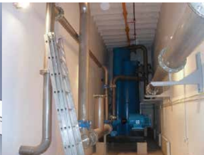
Постројење за испитивање хидрауличних пумпи, модела турбина, хидромашинске опреме и запреминских протомера до 200 l/s
